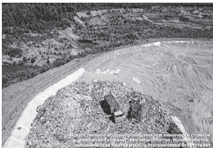
Защиты «от воздействия атмосферных осадков и ветров (укрытие брезентом, оборудование навесом и т. д.)» не наблюдается
